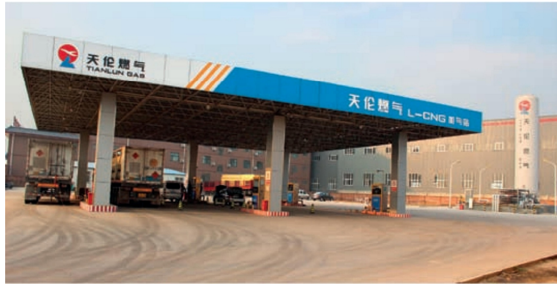
天伦燃气上街加气站
