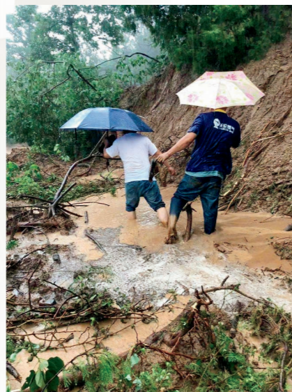
天伦燃气员工前往维修现场
